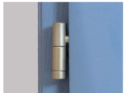
Ferrage par fiches en acier cémenté
